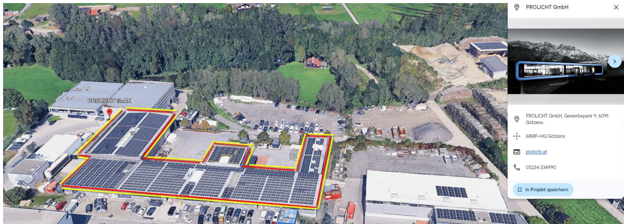
Abbildung 38: PV Anlage GWP 6 - Satellit
